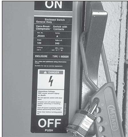
5. Coupez l'alimentation principale de l'outil (disjoncteur/sectionneur du tableau de distribution) et verrouillez le dispositif en position « **OFF** » pour prévenir tout démarrage accidentel. **REMARQUE** : la fourniture Victaulic ne comprend pas le mécanisme de verrouillage.
