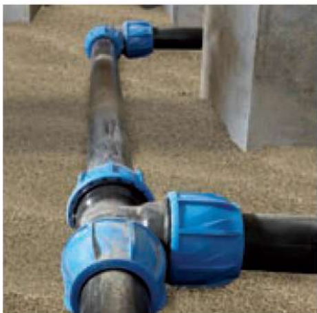
Conduites de distribution d'eau
