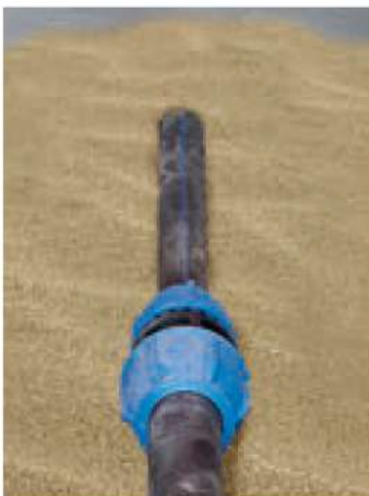
Raccordements aux bâtiments
