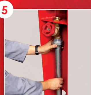
5 Raccordement de l'alimentation
