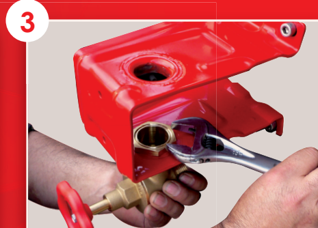
Fixation du robinet d'arrêt
