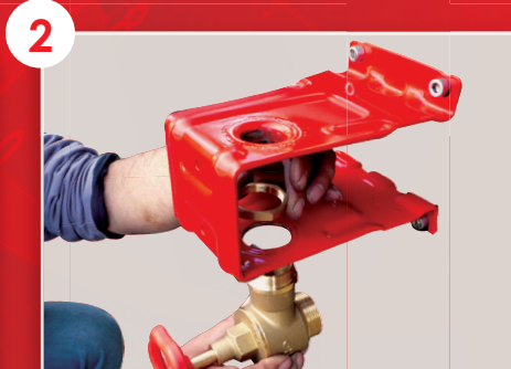
Positionnement du robinet d'arrêt
