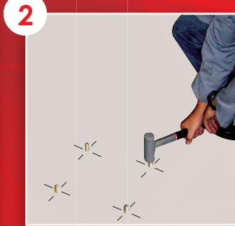
2 Mise en place des goujons
