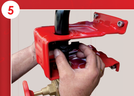
Maintien en position de l'ensemble bobine et tube d'alimentation par un seul collier
