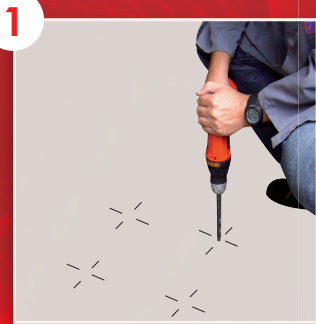
1 Perçage des trous de fixation
